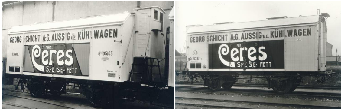
Dvounápravové chladící vozy Gb 105103 Ö.N.W.B. a Gb 323371 K.k.St.B. na přepravu margarínu. Domovská stanice: Schreckenstein.
