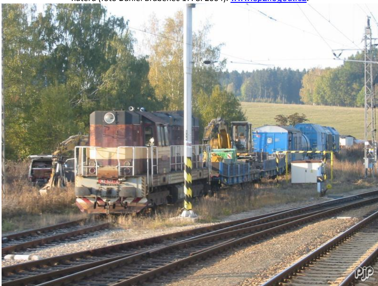
Souprava elektrizace železnic v čele s 742.532 v žst. Rybník. www.foto.pjp.cz .
